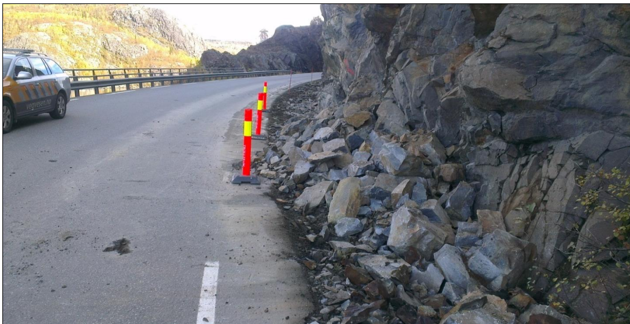
Figur 7: Rensking av løs stein med spett, Kvamskleiva 2012.
