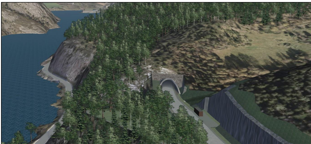
Figur 43: Tunnelportal på Kvam.
